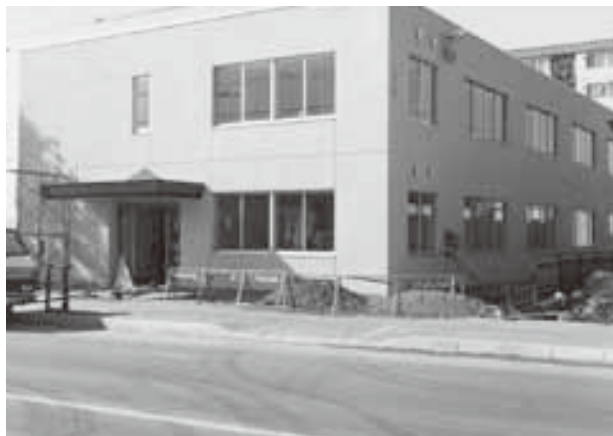
建設途中の帯広医院（当時）
