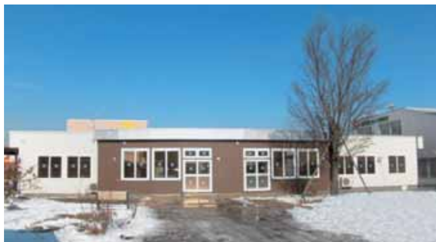
外観が完成し、オープンが近づいてきたデイサービスセンター
