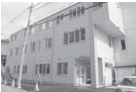
完成した新築棟
