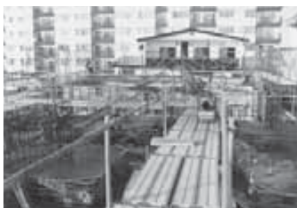
冬を前に順調に 工事が進む
