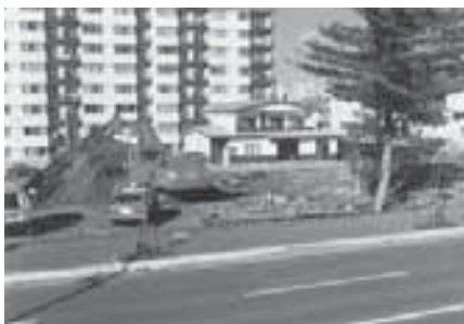
重機が入り地盤を整地
